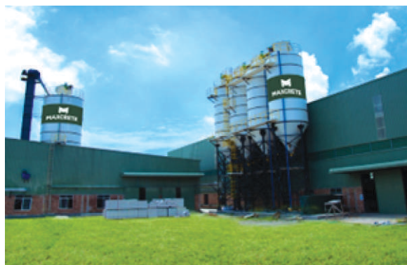
Fig: Maxcrete Limited
